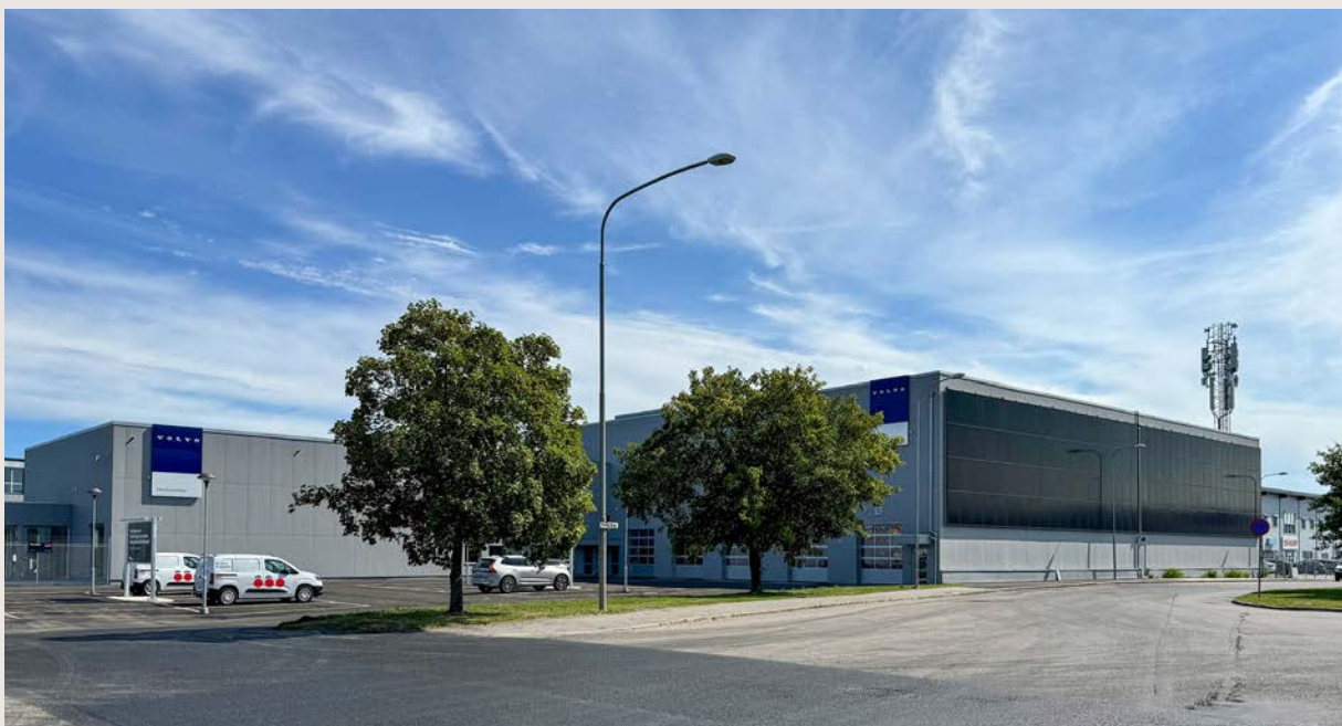
Solpaneler på Risängsgatan i Norrköping.
