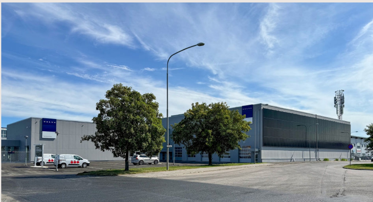
Solpaneler på Risängsgatan i Norrköping.
