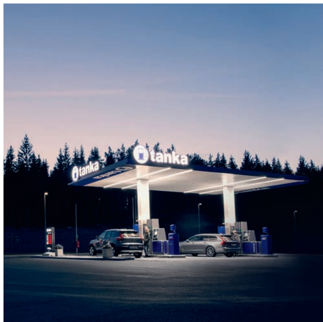
Drivmedel och laddning – ett brett och tillgängligt erbjudande med både traditionella och förnybara alternativ samt utbyggd laddinfrastruktur vid flera av våra anläggningar.
